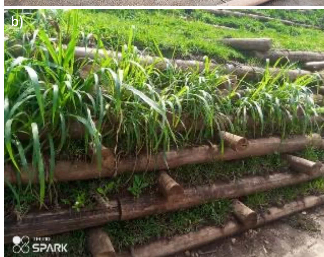
a) Progetto, realizzazione e cantieri didattici per consolidamento e stabilizzazione di scarpata stradale e di corso d'acqua in erosione in Burundi. b) Polifonata con cuneo drenante, grata e palizzate vive.
