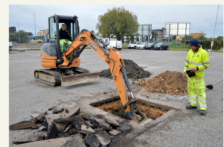
L'asfalto viene rimosso dalla sua sede
